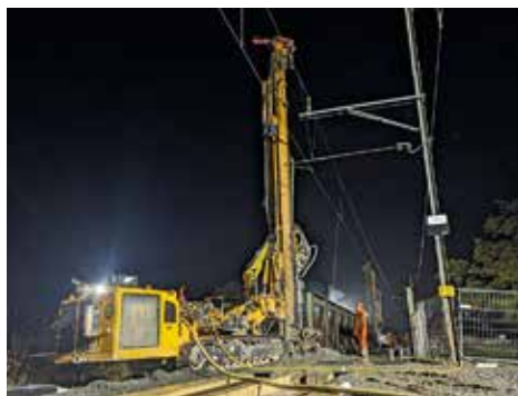
Suivi des travaux de forage de nuit sur le chantier de la Vièze.
