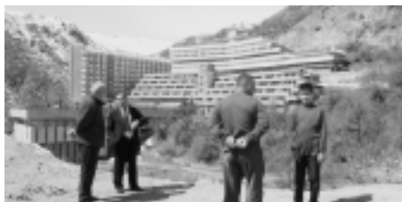
Die touristische Infrastruktur in Tadjikistan ist praktisch inexistent oder, wo vorhanden, nicht dem westlichen Standard entsprechend. Unsere Aufgabe besteht darin, die heutige Situation zu analysieren und Empfehlungen zu Handen der Regierung auszuarbeiten. Das grösste Potential liegt eindeutig beim Ökotourismus und beim Bergsteigen (Foto: U. Hintermann).
