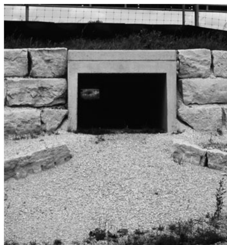
Entrée et sortie du passage pour la petite faune. Ses abords sont aménagés de telle sorte que les animaux ne puissent pas accéder à la voie de circulation en étant dirigés vers l'entrée du tunnel.
