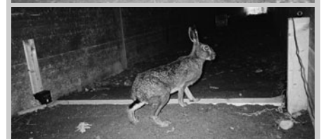
Entrée et sortie du passage pour la petite faune. Ses abords sont aménagés de telle sorte que les animaux ne puissent pas accéder à la voie de circulation en étant dirigés vers l'entrée du tunnel.
